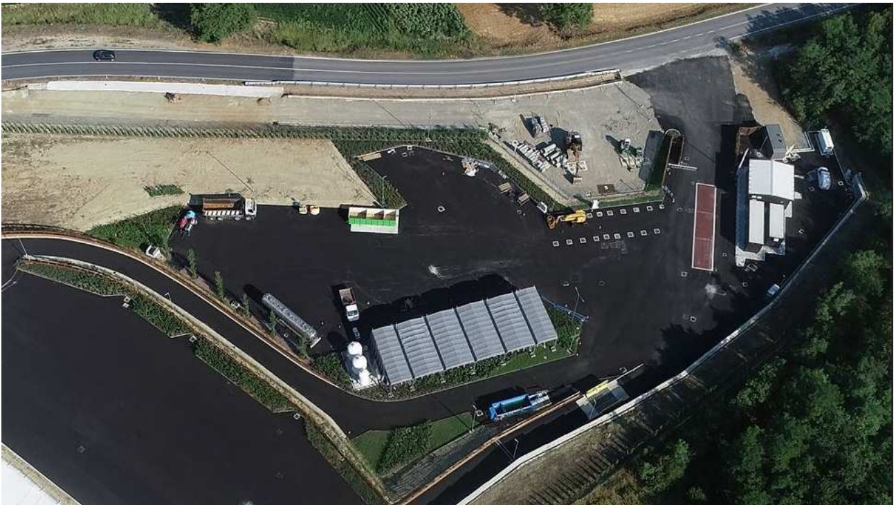
Figura 16: Vista aerea dell'area di ingresso (piazzale, box uffici, Pesa, ecc.) del sito di discarica di Sezzadio
